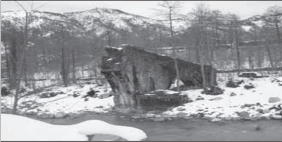
Fotoğraf 11. Orçi Deresi Köprüsü kalıntıları.
