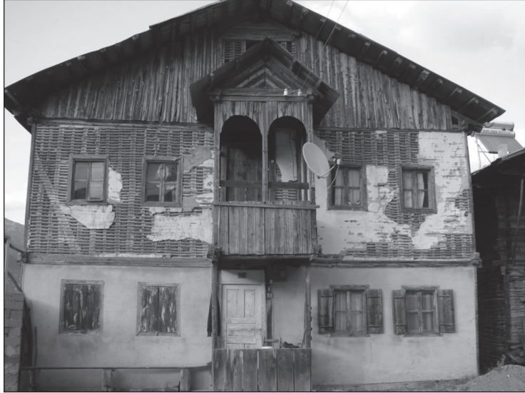
Fotoğraf 7: Araştırma sahasında çakatura dolma tarzında yapılan meskenlere de rastlanılır (Çayağzı köyü).
