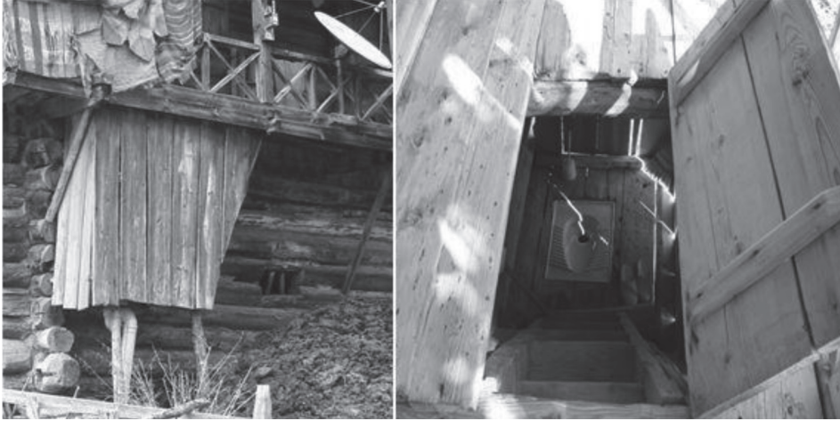
Fotoğraf 9: Geleneksel Şavşat evlerinin karakteristik kısımlarından biri olan asma tuvalet ile ayvan kısmındaki girişinden bir görünüş.
