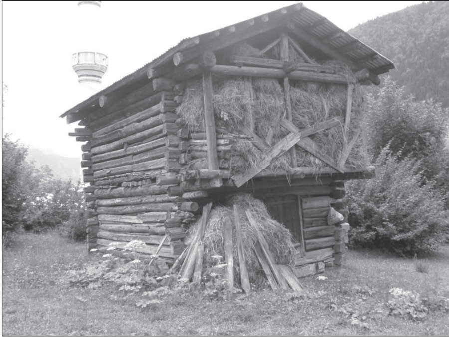
Fotoğraf 11: Yörede ot ve hayvan yemlerinin saklandığı ev eklentilerine merek adı verilir.
