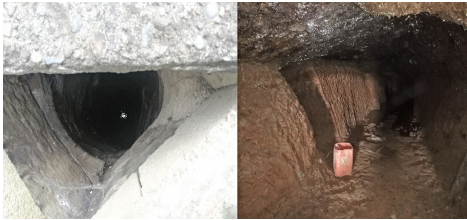
Şekil 5. Kufa Kuyusu'nun iç kısmından (sol) ve kuyudan gizli geçitle ulaşıldığı düşünülen mağaradan (sağ) bir görünüm (Foto: C. Koca).
