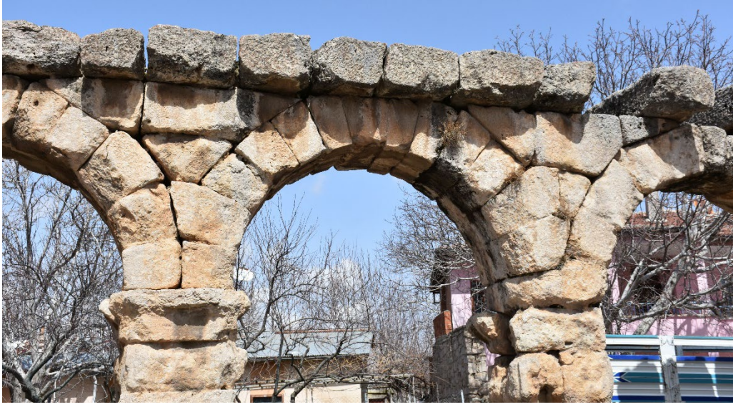
Resim 11. Kemer açıklığındaki boşluğu kapatmak için kullanılan taş bloklar (Tyana Kazı Arşivi)
