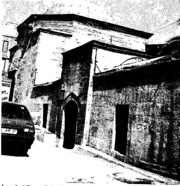
Resim 5: İstanbul/Feyzullah Efendi Külliyesinde kütüphanenin sokaktan görünüşü
