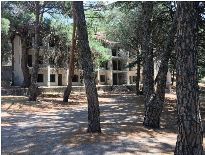
Fotoğraf 12 Eski sanatoryum binası ( Yazarlarca çekilmiştir. )
