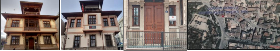
Görsel 43: Noter Ragıp Anadolu evi cephe görünümü ve konumu (Aygör ve diğerleri, 2010)(Yazar,2023).
