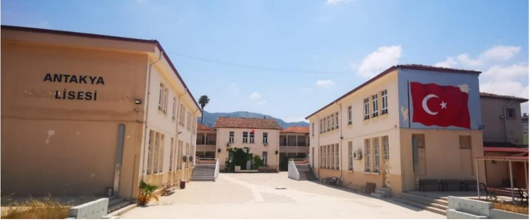
Şekil 3. Antakya Lisesi genel görünümü
