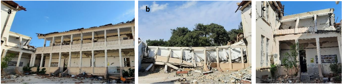
Şekil 6. Betonarme iskelet taşıyıcılı açık koridor kısımlarının deprem davranışı. a)3 No.lu yıkılmamış kol, b)1 No.lu yıkılmış kol, c) 2 No.lu kısmen yıkılmış kol
