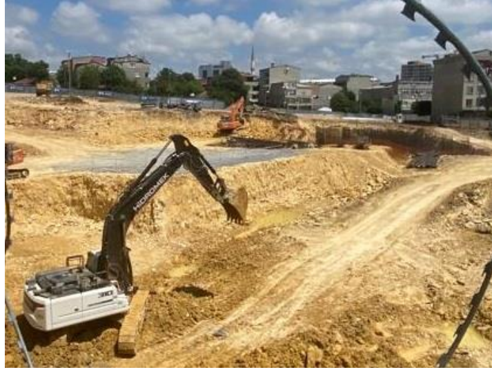
Fotoğraf 10. İkitelli Köyiçi Mevkii 1. Etapta Devam Eden İnşaat Çalışmaları (2023).
