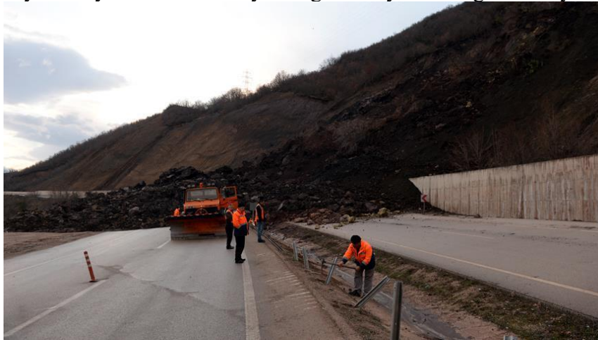
Şekil 8. Tokat Kenti Niksar-Reşadiye karayolu üzerinde yaşanan heyelan (Heyelan, 2023). Figure 8. The landslide on the Niksar-Reşadiye highway in Tokat City (Heyelan, 2023).
