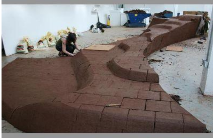
Fotoğraf 1: Zemine aktarılan tasarıma göre tuğla dizimi. (Heeney, 2003)
