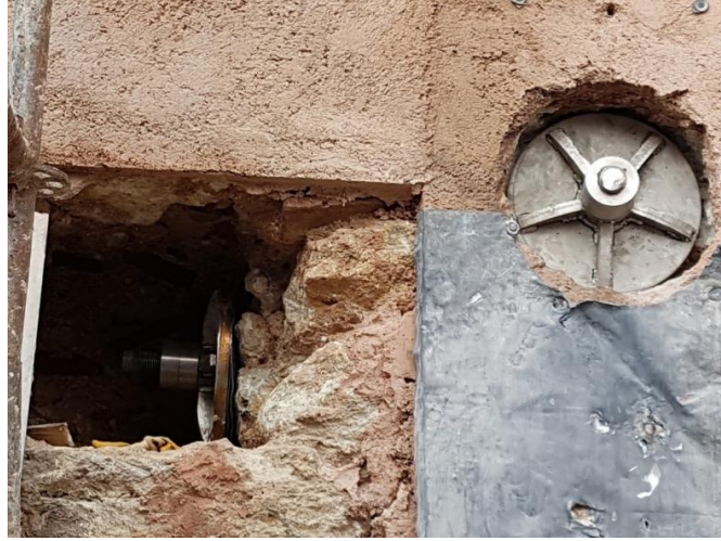
Şekil 4.2.4. İki yönde yapılan gergilerin durumu (Figure 4.2.4. The application of the tension rods in two orthogonal directions)
