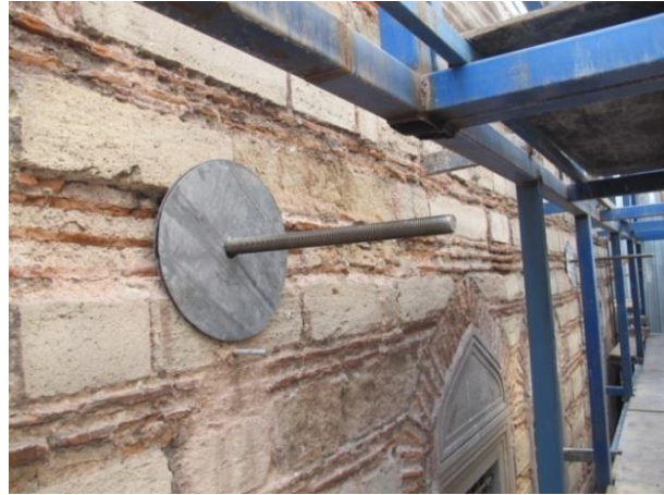
Şekil 4.1.6. Mısır Çarşısı Balıkpazarı Kapısı üstü odalarının paslanmaz çelik gergiler ile güçlendirilmesi (Figure 4.1.6. Strengthening of the rooms above the Spice Bazaar's Balıkpazarı Gate with stainless steel tension rods)
