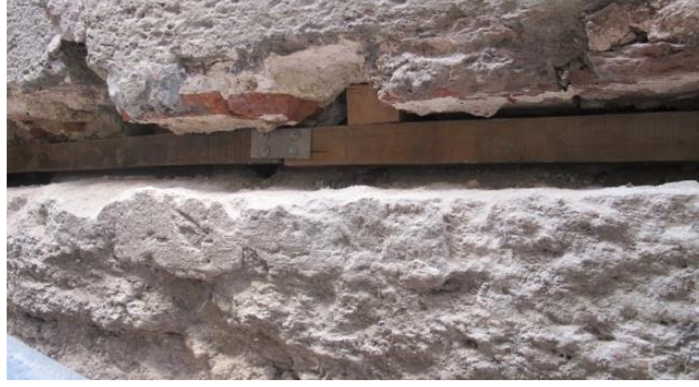
Şekil 4.1.2. Mısır Çarşısı duvarlarında açılan hatıl kotları ve yeni ahşap hatılların yerleştirilmesi (Figure 4.1.2. Lintel levels on the walls of the Spice Bazaar and replacing timber lintels)
