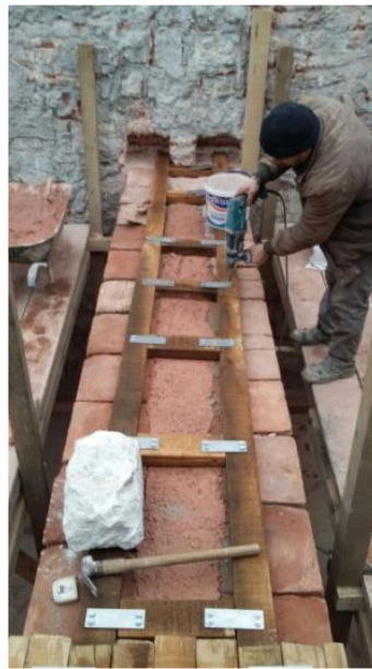
Şekil 4.1.4. Yeni örülen çift cidarlı tuğla duvar ve hatıl uygulaması (Figure 4.1.4. Construction of double-walled brick wall and lintel application)
