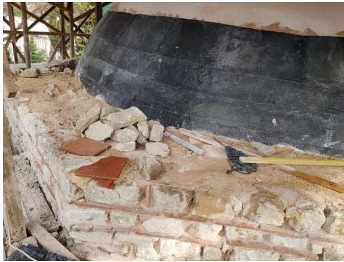
Şekil 4.2.5. Kubbe kasnağına uygulanan karbon elyaf kuşaklama (Figure 4.2.5. Carbon fiber reinforced polymer application in tension region of the dome)
