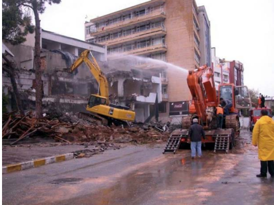
Şekil 5. Antalya Hükümet Konağı Yıkımı (URL-1).
