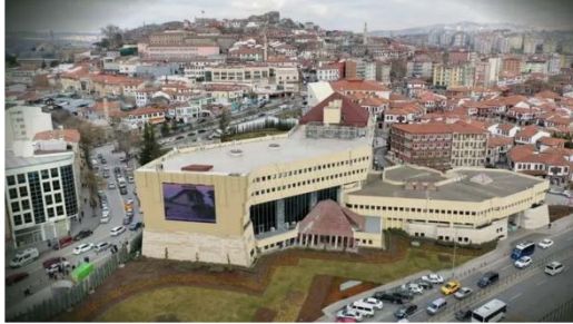
Şekil 13. İki Bloğu Yıkılmış Binanın Görünümü (URL-5).
