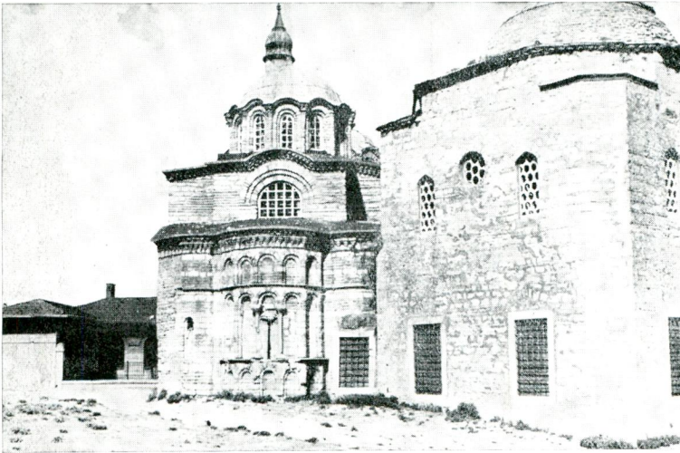
Res. 2 — Paraklesiyon ile Türkler tarafından ilâve olunan mihraplı kısmın dıştan görünüşü.
