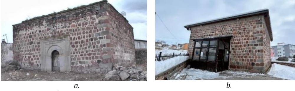
Şekil 12. Ardahan Müderris İbrahim Efendi Camii kuzey cephesi restorasyon öncesi (a) [30], restorasyon sonrası (b)
