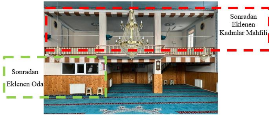
Şekil 11. Ardahan Mevlüt Efendi Camii kuzey duvar iç görünüşü sonradan eklenen kadınlar mahfili ve oda
