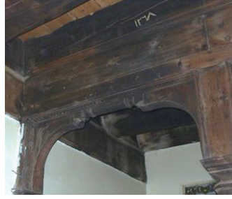
Fotoğraf 8. Kemer-kiriş sistemi ve yapılış tarihini gösteren kitabe
