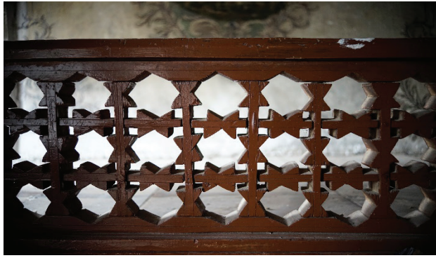
Fotoğraf 31. Yüklük bölümü ahşap korkuluğu
