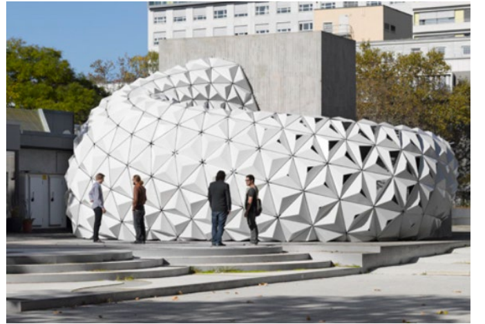
Şekil 7. ITKE Stuttgart Üniversitesi tarafından tasarlanıp inşa edilen, 388 biyoplastik piramitten oluşan ArboSkin (URL 3)
