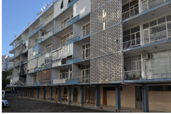
Şekil 12. Yalı Apartmanı'nın cephesi (Kaynak: Funda Alyanak Kaya kişisel arşivi, 2022)
