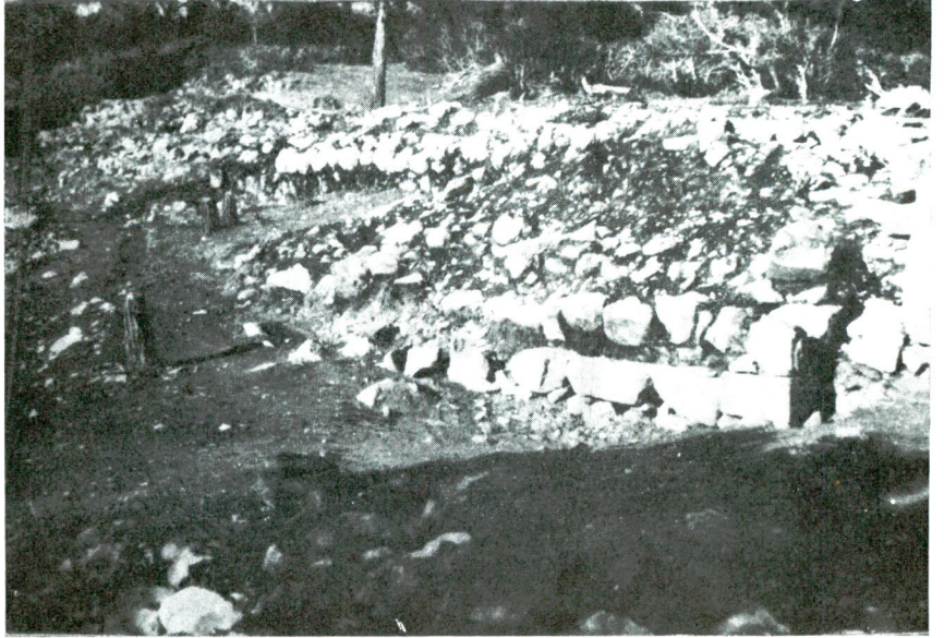
Res. 4 b — Yukarı Kazı alanındaki giriş binası ile birleşerek burada bir köşe kulesi teşkil eden surun güney-doğudan görünüşü.
