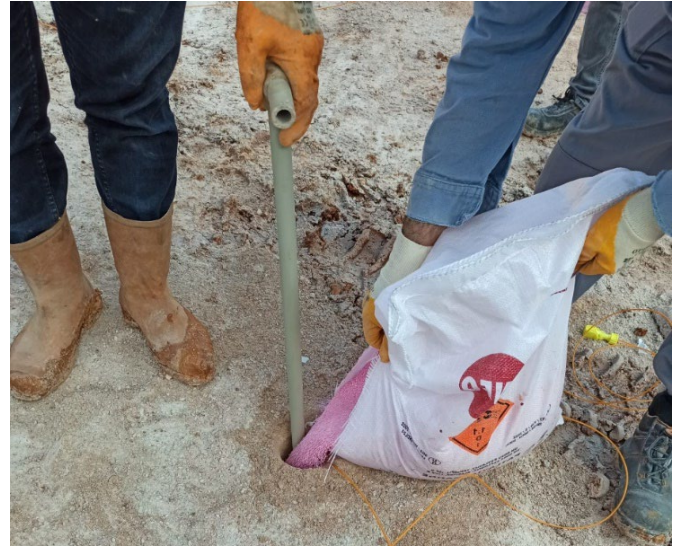
Şekil 9. Deliklerin doldurulması ve sıkılama işlemi
