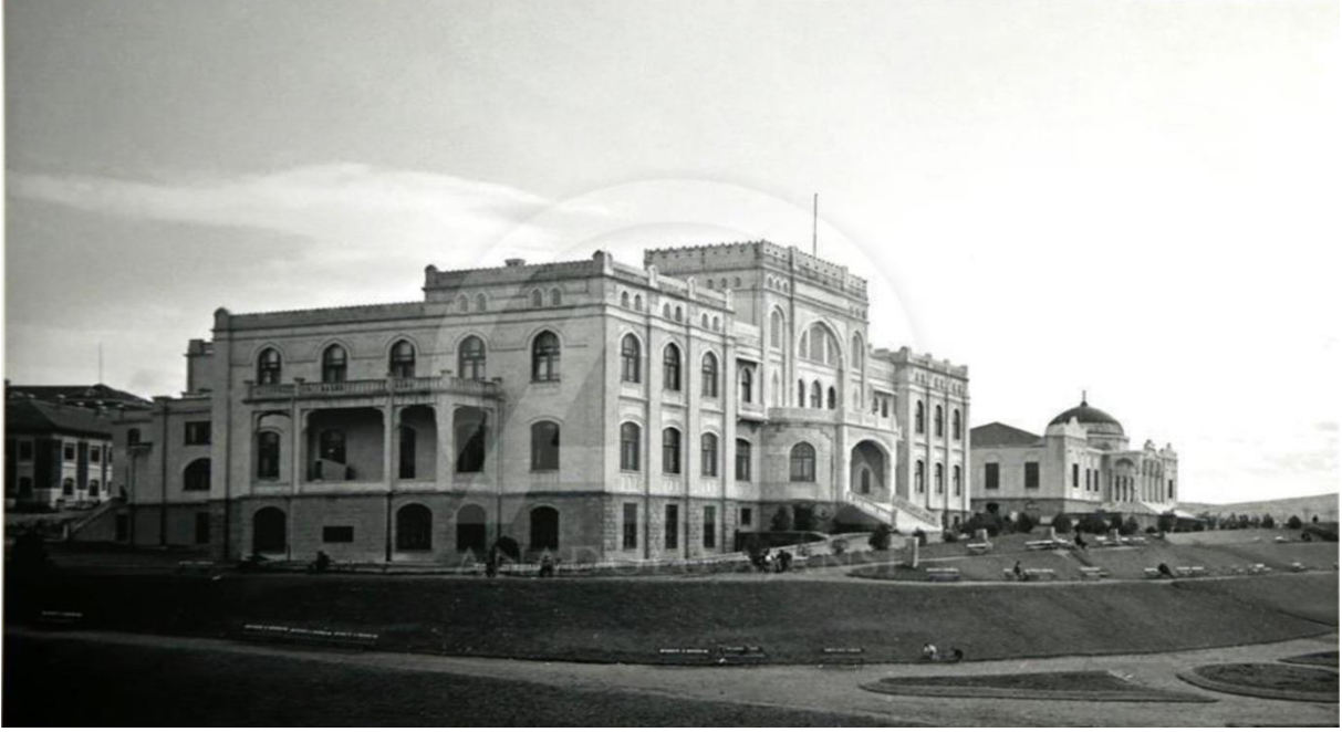
Görsel 2: Türk Ocağı (Halkevi, Devlet Resim ve Heykel Müzesi) Binası (Solda) ve Etnografya Müzesi (Sağda), 1930'lu yıllar, Ankara, Namazgah Tepesi (URL-12).
