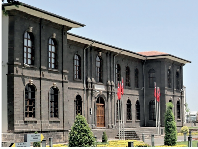
Resim 46. Vedat Tek'in mimarlığını yaptığı Diyarbakır Hükümet Konağı (Foto: İsmail Küçük)
