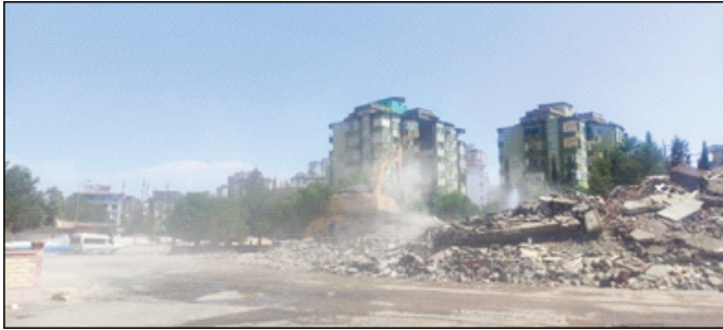
Şekil 2. Deprem sonrası bina yıkımından bir görüntü.
