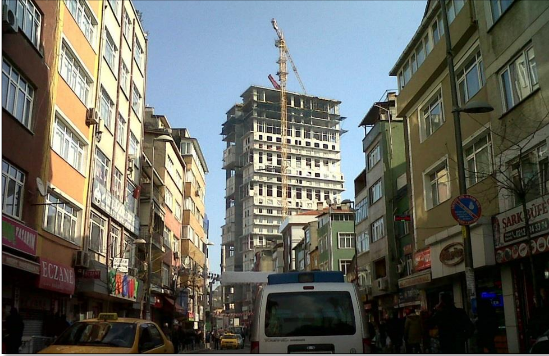
Şekil 2: Dönüşüm Projeleri ve NEF Flats Levent 163 İnşaata (Şubat 2012) (Url-2)
