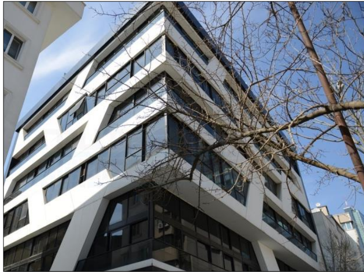
Şekil 17: Projenin Sokak Köşesinde Ön Cephesi (Url 5)
