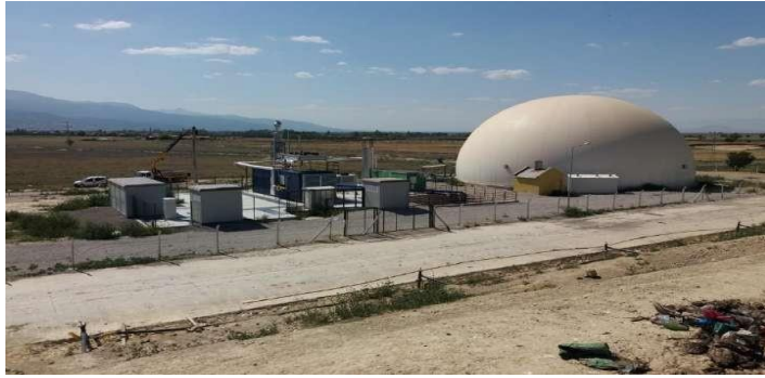
Görsel 10. Akşehir Enerji Üretim Tesisi
