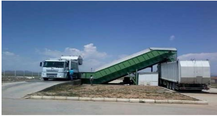
Görsel 11. Kulu Transfer İstasyonu
