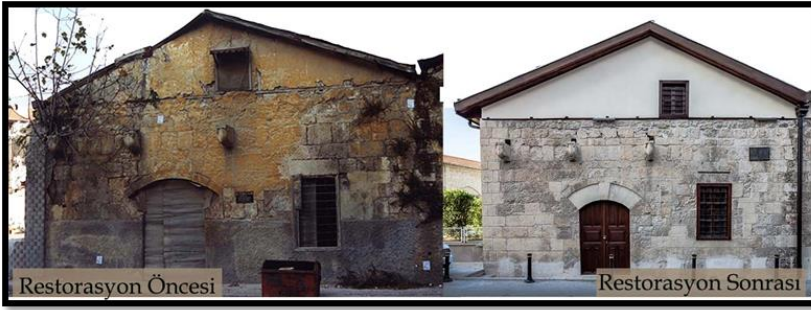
Şekil 9: Niteliğini koruyan taşların sağlıklılaştırılıp tekrar kullanımı (Kaynak: https://www.arkitera.com ,düzenlenmiştir.)
