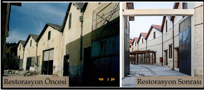
Şekil 12: Sıvalı alınlıklar ve izlenebilir taş duvar örgüsü (Kaynak: https://www.arkitera.com , düzenlenmiştir.)
