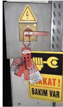
Şekil 4. Otomatik Yatay Kalıplama Hattının Soğutma Tünelinde Derece Devrilmesine Müdahale Çalışması Sırasında EKED Uygulaması (LOTOTO Implementation During the Response Study for Mold Tilt in the Cooling Tunnel of the Automatic Horizontal Molding Line)
