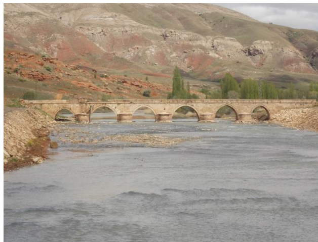
Foto.1. Boğaz Köprüsü Genel Görünüş.
