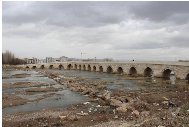
Foto.2. Eğri Köprü Genel Görünüş (Elmas Ş. P.)
