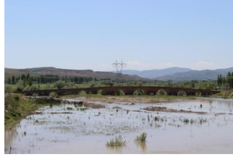
Foto.6. Yıldız Köprüsü Genel Görünüş(Elmas Ş. P.)
