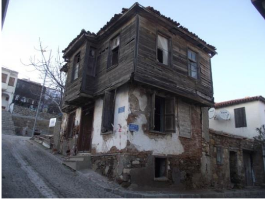
Şekil 22. Katı Ahşap karkas yapı[9]
