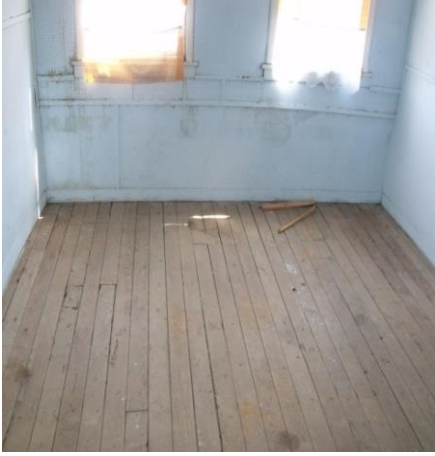
Şekil 31. Ahşap zemin döşeme kaplaması [9]
