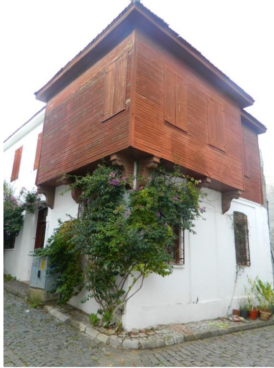
Şekil 24. Bozcaada konutlarında ahşap yalı baskısı ve ahşap payanda örnekleri[9]
