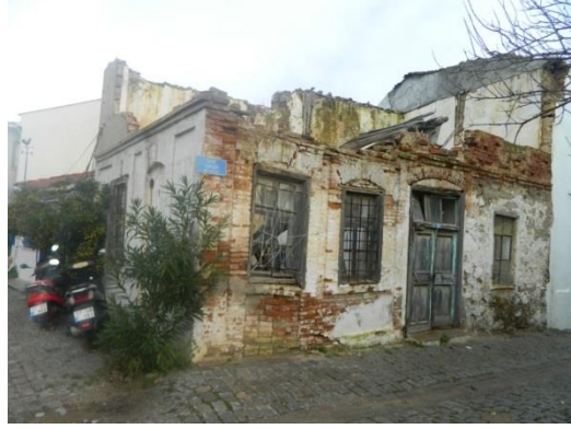
Şekil 20. Tuğla malzemeli kagir konut örneği[9]
