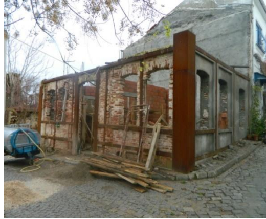
Şekil 19. Tuğla malzemeli kagir konut örneği[9]
