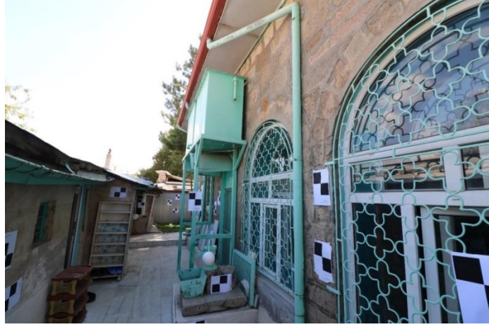
Şekil 6. Yapının Kuzey Cephesi Görünüş (Kaynak: Kültür İnşaat Restorasyon)
