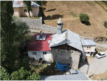
Görsel 4. Yapının Güney Cephesi
