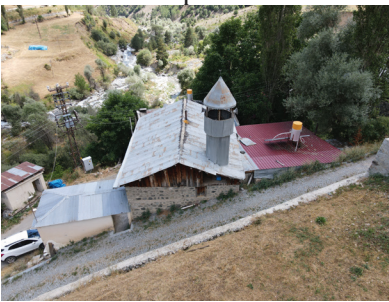
Görsel 6. Yapının Kuzey Cephesi
