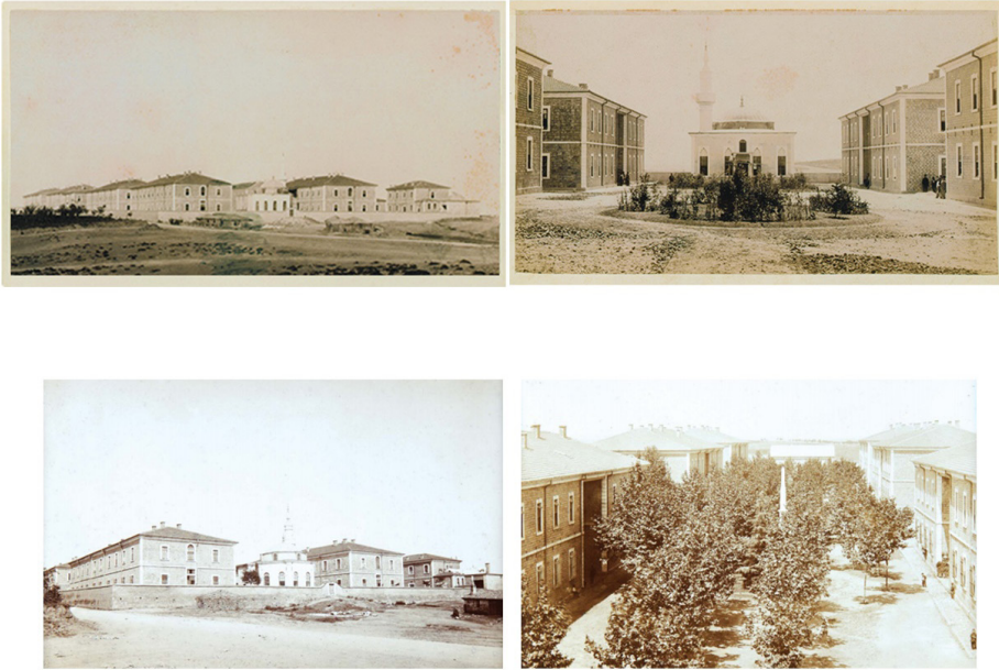
Şekil 5. Darülaceze dış cephe ve avlu görünümü, 1895.
