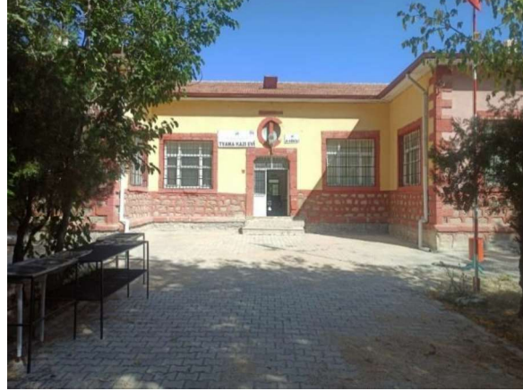
Görse 4. Etiler İlkokulu Batı Cephesi.
