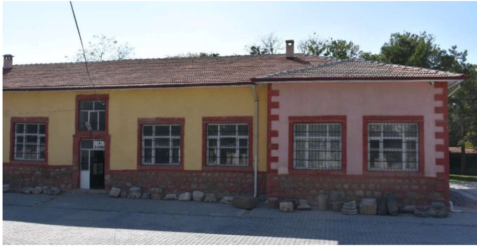
Görsel 6. Kemerhisar Etiler İlkokulu Kırma Çatı.
