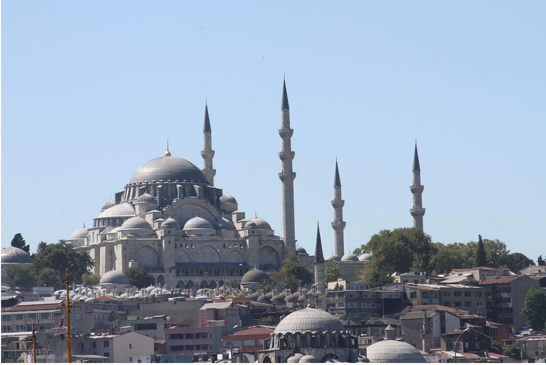
Şekil 1. Haliç' ten Süleymaniye Camisinin ve payandalı kible duvarının görünüşü [1]
