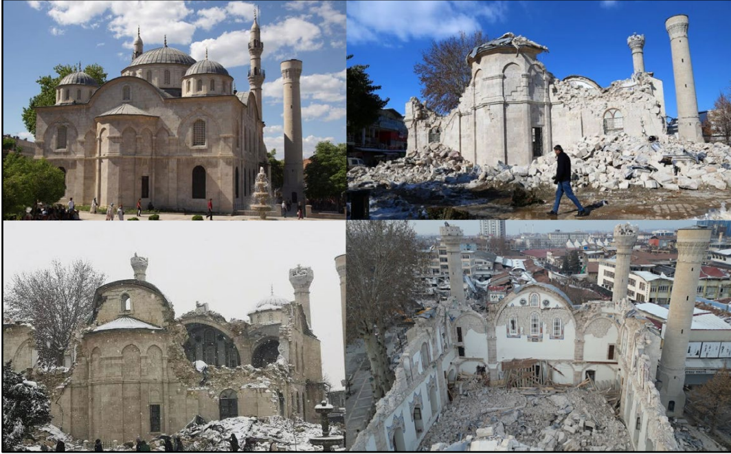
Fotoğraf 3. Yeni Cami'nin Depremden Önce ve Sonraki Hali
