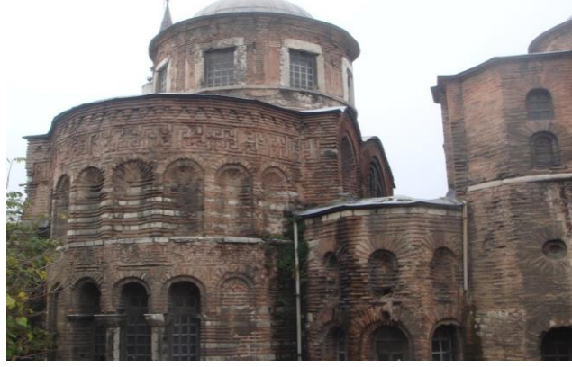
Şekil 1. Lips Manastır Kilisesi/Fenari İsa Camii apsis cephesi [4]
