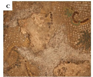
Yapım katmanlarında ayrışma detay görünüm.
