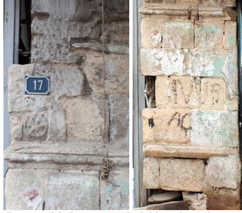
Foto.15: Batı giriş kapısı üzerindeki süslemeden ve düzgün kesme taş kapıdan detay bir görünüm
