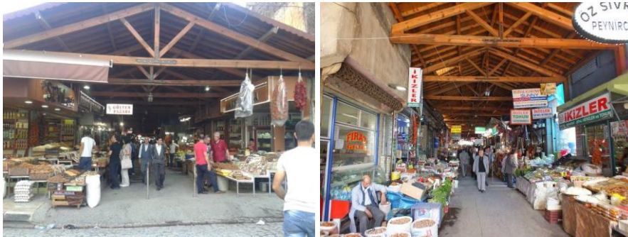
Foto.3: Restorasyon öncesi kuzey giriş kapısından ve içten görünüm (2018)
