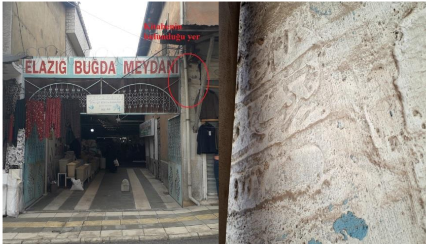
Foto.6: Kitabenin bulunduğu doğu kapısı ve kitabeden detay görünüm
