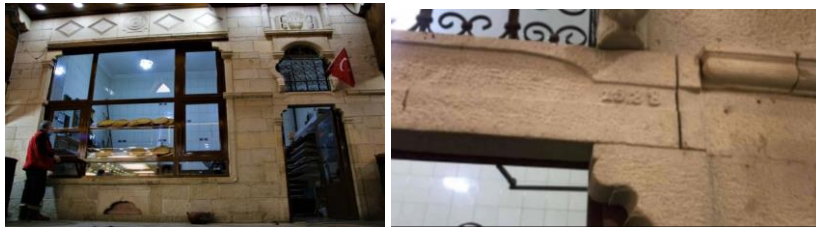
Foto.2: Kapalı Çarşı Fırınının kuzey giriş cephesi ve kitabeden bir görünüm(2020)
