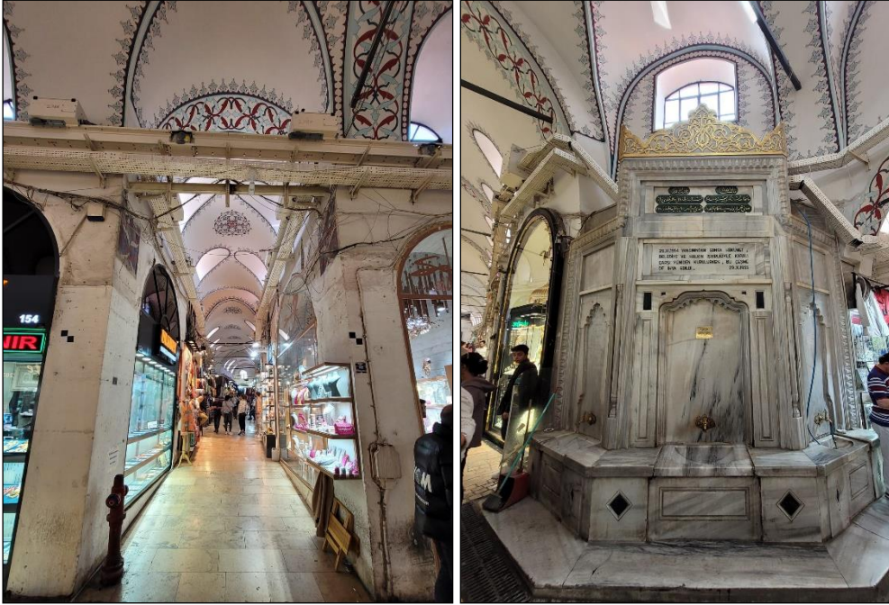
Şekil 7. Restorasyon sonrası kapalı sisteme alınmış kablolar (Orijinal, 2023)
