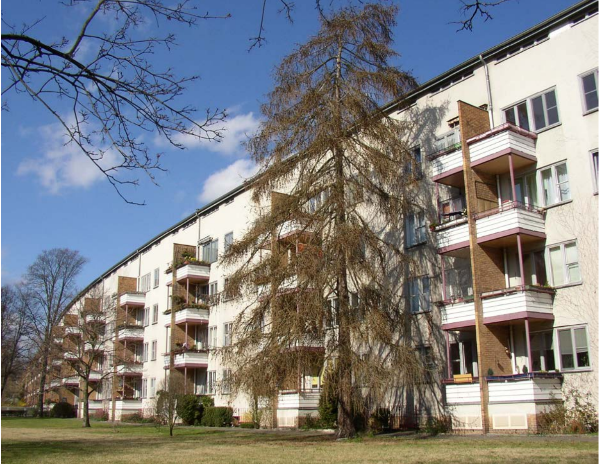
Şekil 7. Güney Cephe (URL-5).
