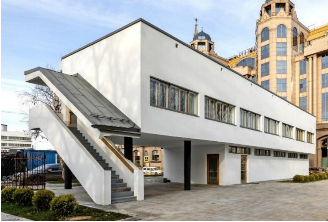
Şekil 22. Çamaşırhane (restorasyon sonrası) (Ateş Can, Bakır, 2021).
