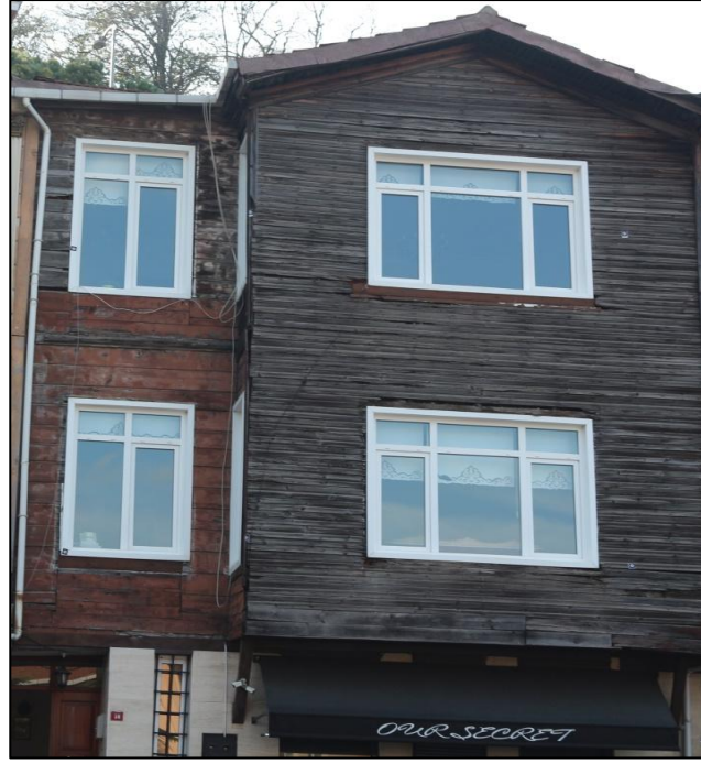
Şekil 1. Çalışması yapılacak olan 2. derece tarihi eser niteliğindeki yapı
