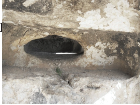
Res. 16 Mezar 3'deki tahribatlar ve Mezar 4'e geçiş sağlayan açıklık
