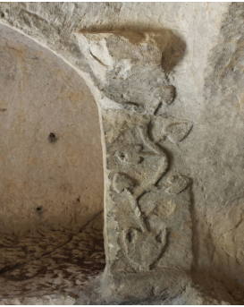
Res. 20 Mezar 2 kuzey duvarı
