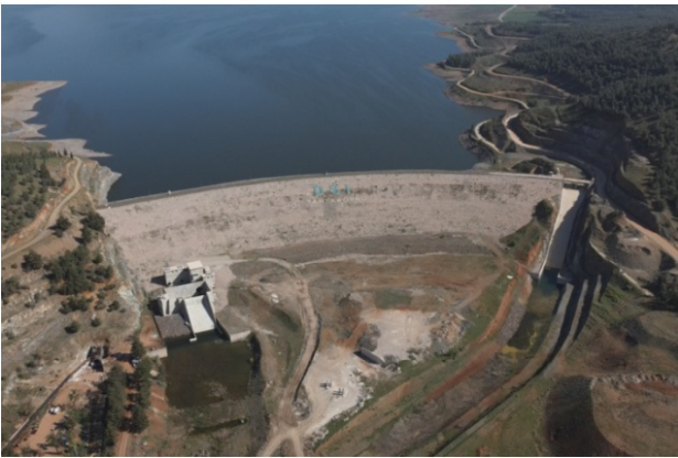
Şekil 3: Çalışma alanı: Tahta Köprü Barajı.
