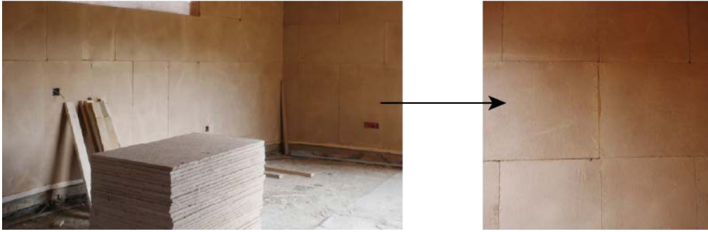
Şekil 9. Yapının iç cephesinde toprak panel uygulaması (URL-1).
