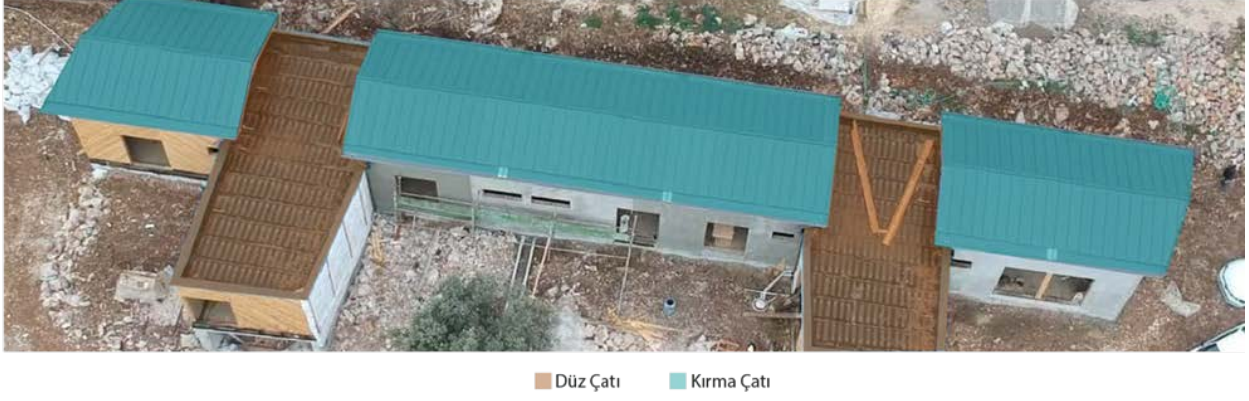
Şekil 11. Yapıda kullanılan kırma ve düz çatı sistemleri (URL-1; Yazar, 2023).
