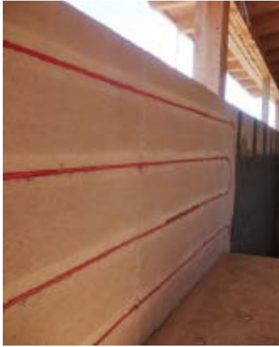
Şekil 18.: YBE Kadiovacık Biyo Evinde duvardan ısıtma için voltajlı elektrik rezistans tellerinin döşenmesi ve duvardan ısıtma sisteminin kullanımı ve arayüzü (URL-1).
