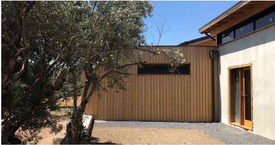
Şekil 7. Yapının doğu cephesinde ahşap kaplama ve güney batı cephesinde sıva uygulaması (URL-1).
