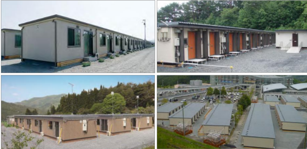
Şekil 7. Japonya’da afet sonrası kullanılan geçici afet konutları (Goda, 2015, s.25)
