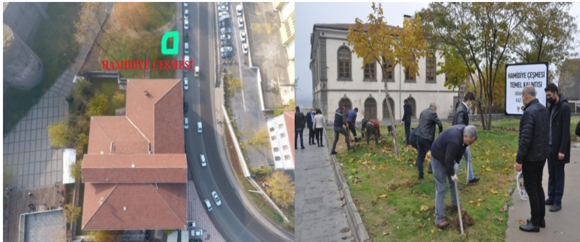
(a) (b) Şekil 12. Hamidiye Çeşmesi Kazı Çalışmaları Genel Görünüşleri (Kaynak: a, b, Diyarbakır Müze Arşivi, 2021).
