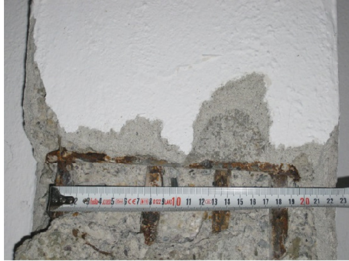
Şekil 3. Kolonlarda sıyırma işlemi yapılması.
