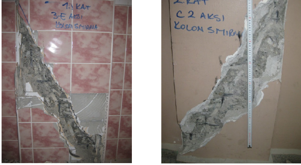
Şekil 3. Kolonlarda sıyırma işlemi yapılması.
