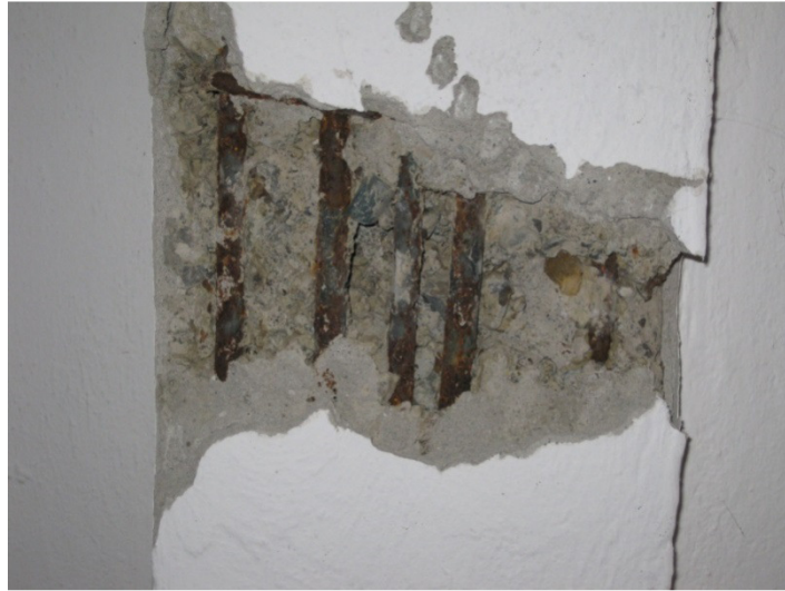
Şekil 4. Kirişlerde sıyırma işlemi yapılması
