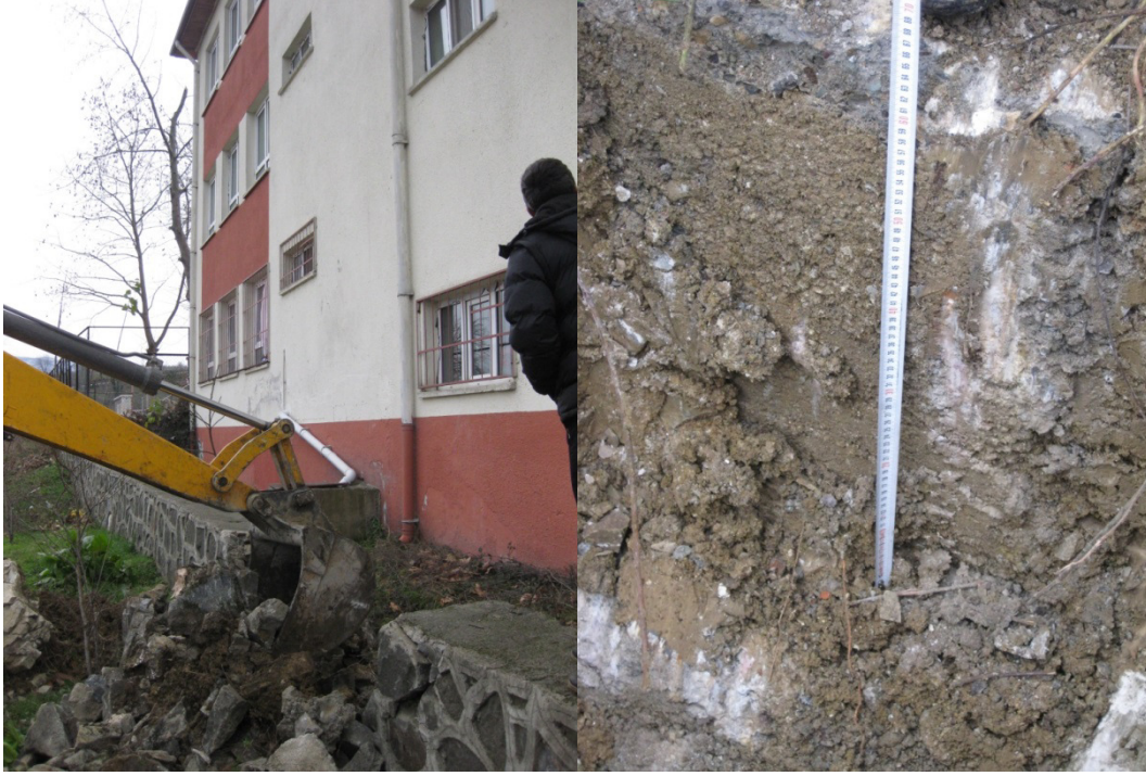
Şekil 7. Binanın dışından ve içinden açılan temel çukurları
