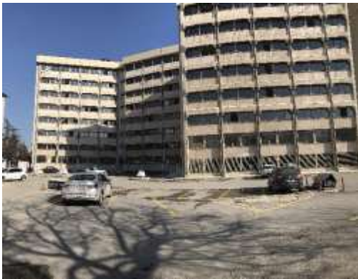
Resim 43. Konya Belediye Binası'nın dönem özelliklerini yansıtan cephe görselleri
