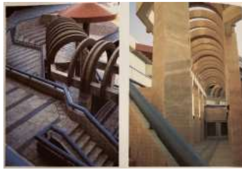
Resim 29. Altındağ Belediye Binası arka cephesindeki çarşıya ait imgeler (Karaaslan ve Öztekin, 2001)
