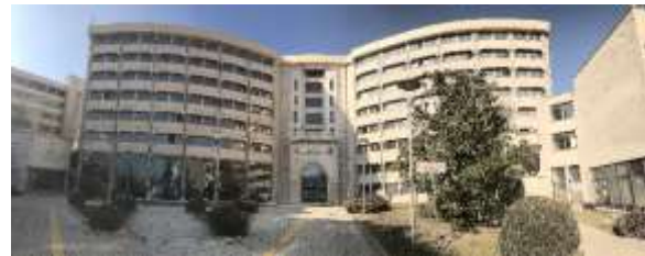
Resim 38. Konya Belediye Binası avlusu ve bloklarına ait görsel
