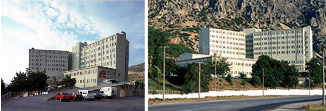
Şekil 19. Kemik Hastalıkları Hastanesi cephe özellikleri (Özaltın İnşaat, 2021).
