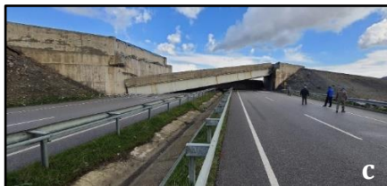
Şekil 6. 06 Şubat 2023 Depremlerinde Oluşan Afetin Boyutları ve Kentsel Etkilerine Örnekler. Adıyaman Gölbaşı İlçesinden Zemin Sıvılaşmasına Bağlı Bir Yapı Hasarı (a). Kahramanmaraş Şekeroba Tren Yolunun Fay Tarafından Ötelenmesi (b). Gaziantep Nurdağı İlçesinde Deprem Sırasında Çöken Bir Otoyol Üst Geçiti (c). Hatay Döver Köyünde Kaya Düşmeleri (d).
